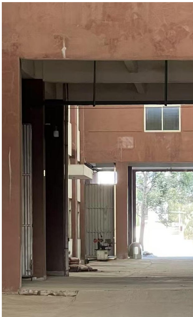
图 2-3 项目现状照片
